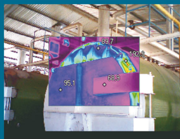
Una caldera en buen estado.
